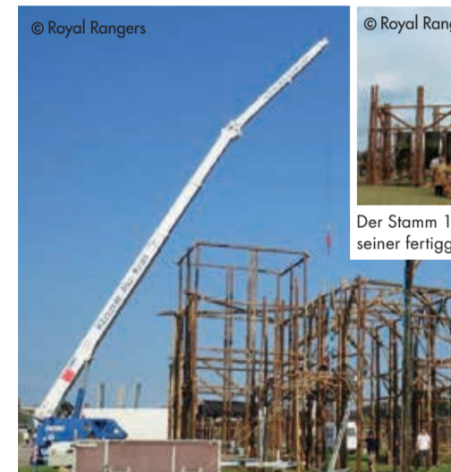
Der K23-33 TSR City beim Aufstellen der „Wände“
