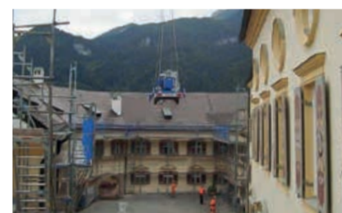
Der Hubschrauber setzt den Kran im Innenhof ab.
